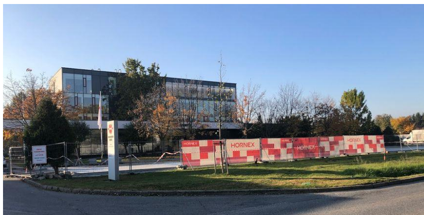
Rekonštrukcia areálových komunikácií v areáli spoločnosti Würth, Bratislava
