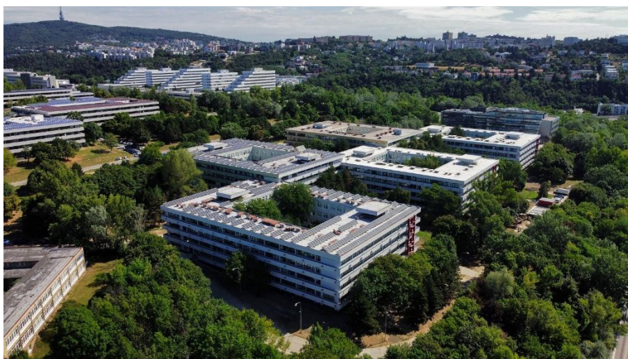
Zateplenie pavilónov - ACCORD, Bratislava ACCORD Rekonštrukcia vnútorných a vonkajších rozvodov, Bratislava
